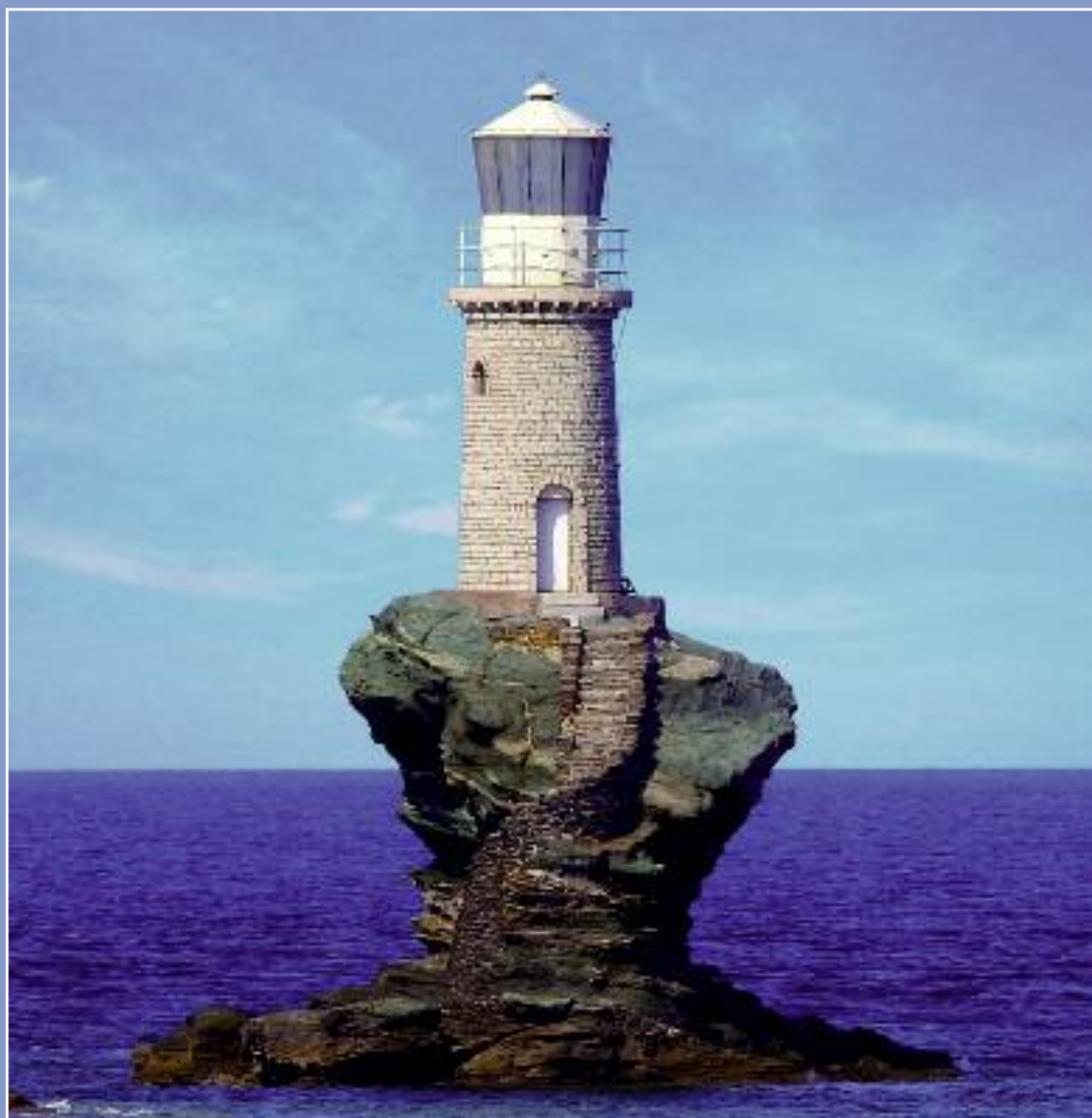
Ο Φάρος Τουρλίτης στη Χώρα της Άνδρου. Κατασκευάστηκε το 1887 έχει ύψος 7 μέτρα, εστιακό ύψος 36 μέτρα και ήταν καταδιοπτρικός Ε΄ τάξεως με φωτοβολία 11 ν.μ.
